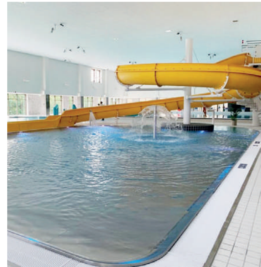
Tårnby Kommune indviede i 2020 Vestamager Svømmehal, som har kostet i omegnen af 130 millioner kroner at anlægge.
